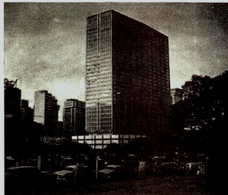
Ed. Central - 12.000 m 2 estrutura protegida com "Limpet"
